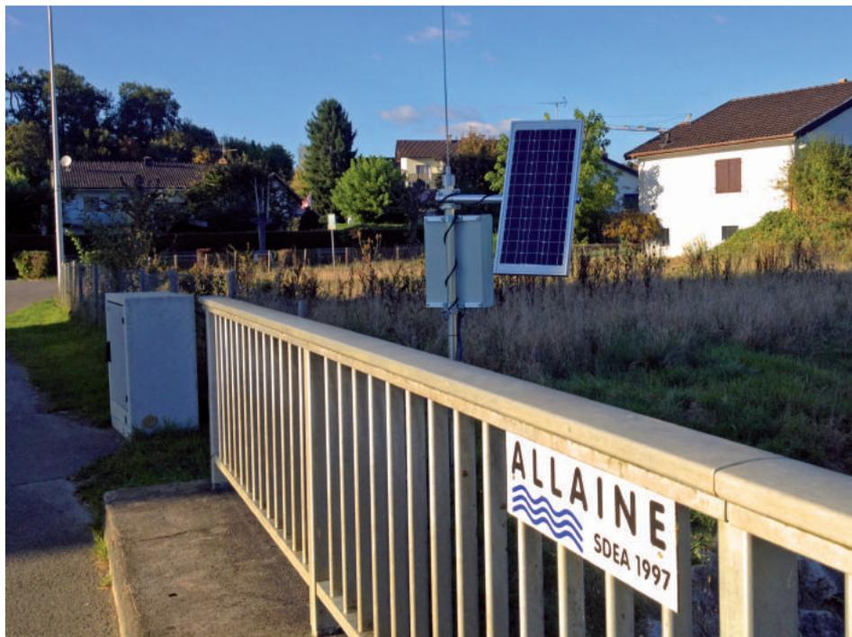
*La station de mesure installée derrière le pont à la rue du Mont-Terri. Photo: Alan Stalder.*
